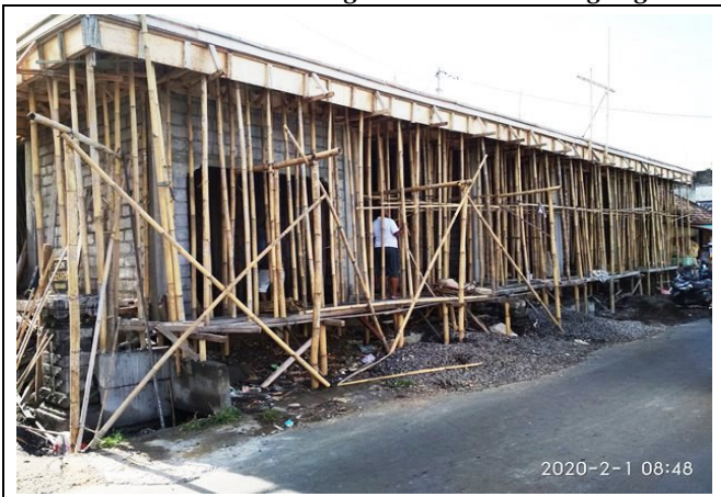
Der Klassiker im Bau: Verschalung der Betondecke
