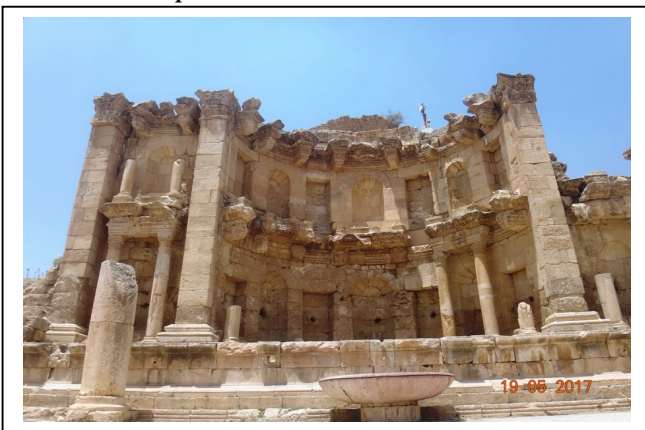
Die zentrale Wasseranlage Nymphaeum
